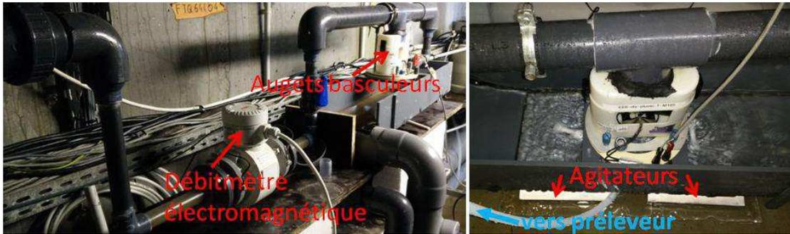
Figure 2. Systèmes de mesure et de collecte équipant les sorties de drains et de surface (noue standard).
